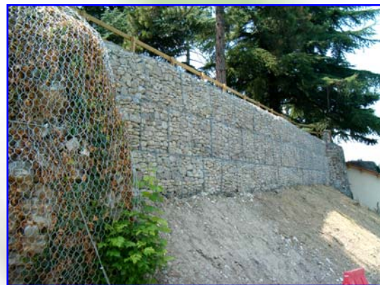
Foto. 3 – Konsolidierungsbauwerk nach Beendigung der Arbeiten
