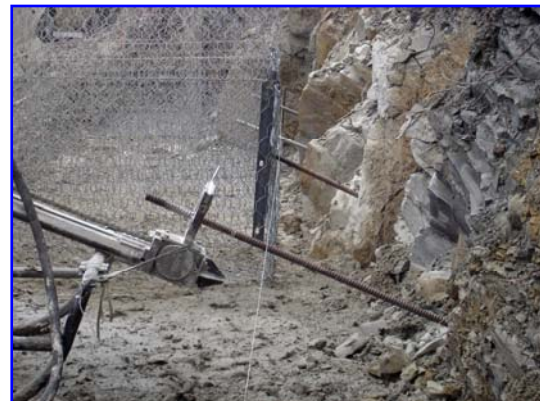
Foto. 1 – Realisierung der Vernagelungen
